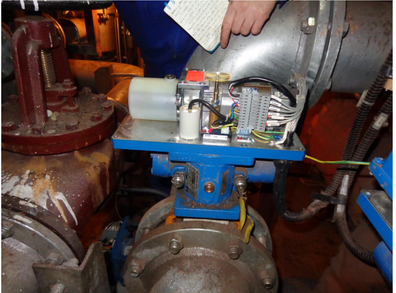
Rys. 12 Siłownik elektro-hydrauliczny
